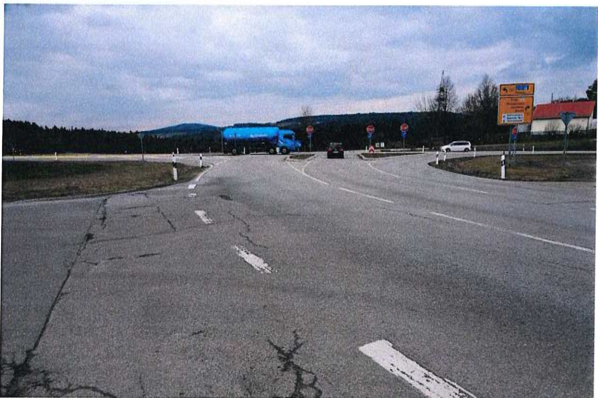
Abbildung 5: Blick auf die bestehende Einmündung aus südlicher Richtung mit Umweg zum PKW am rechten Bildrand
