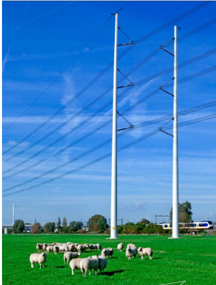
Abbildung 10: TenneT Wintrack-Mast (Niederlande)
