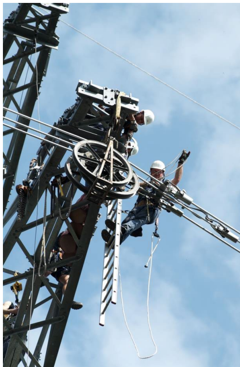
Abbildung 34: Leiterseile liegen während des Seilzugs in den Laufrollen
