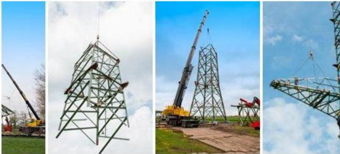
Abbildung 33: Mastmontage mittels Mobilkran
