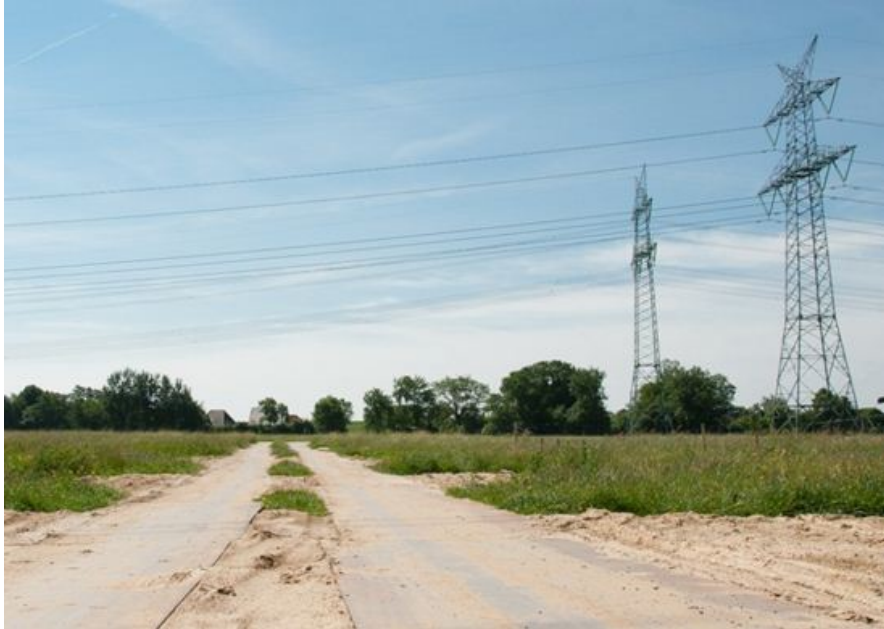
Abbildung 31: Beispiel für eine temporäre Mastzufahrt
