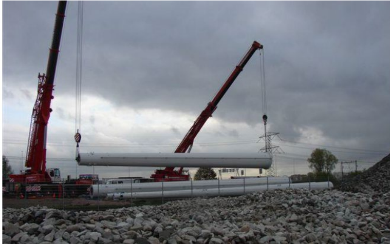
Abbildung 13: Aufstellen von Vollwandmasten mit Kränen
