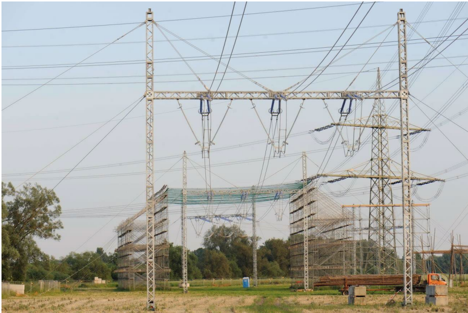
Abbildung 35: Freileitungsprovisorium
