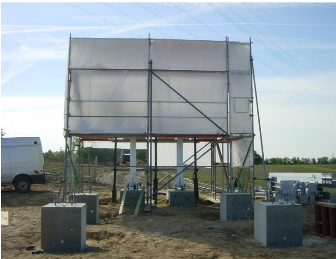
Abbildung 16: Einhausung Freiluftendverschlüsse
