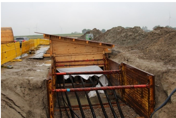
Abbildung 25: Bild eines Muffenverbaus
