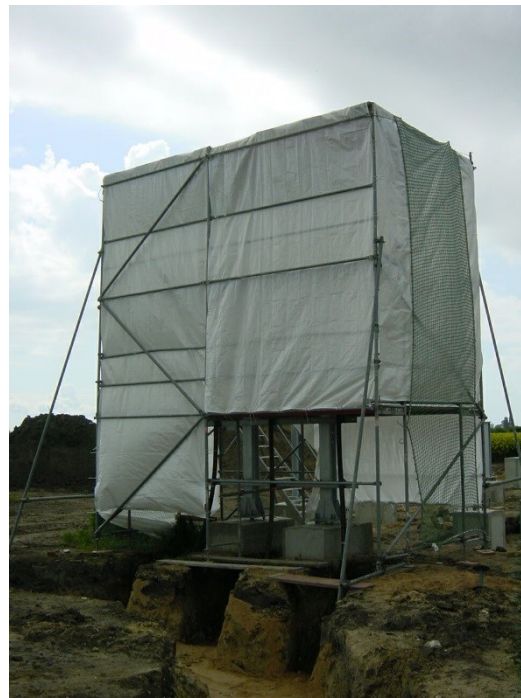
Abbildung 17: Einhausung Freiluftendverschlüsse
