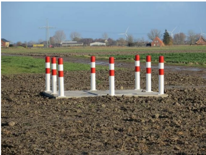
Abbildung 26: Bilder einer Crossbonding-Muffe als unterirdisches Bauwerk
