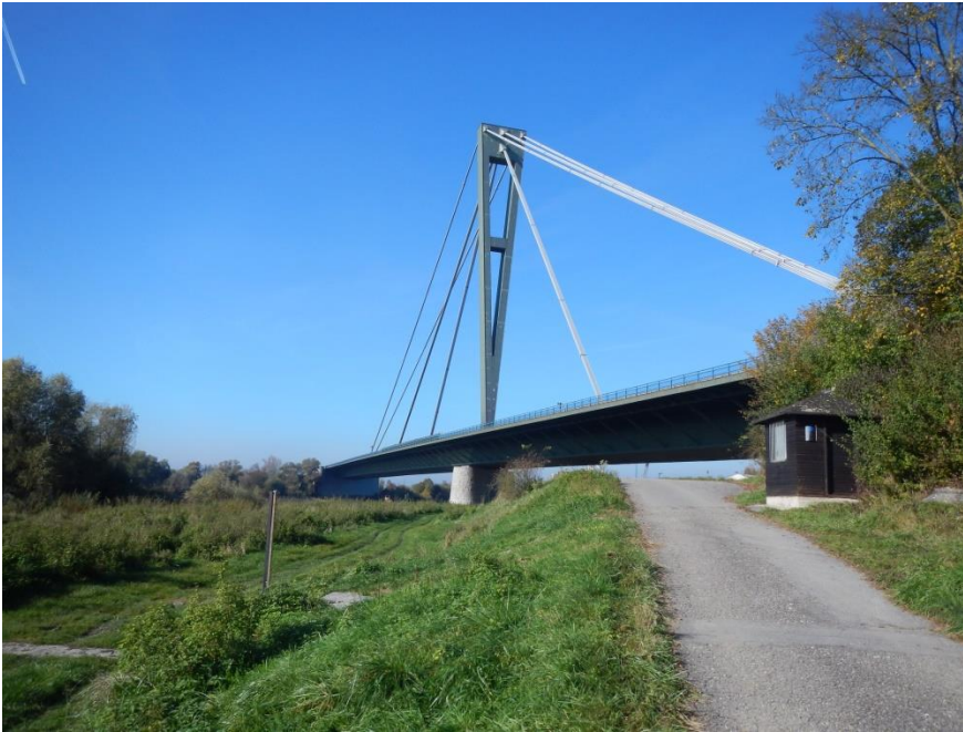
Abbildung 2.8 Pylon der Donaubrücke, Blick nach Westen
