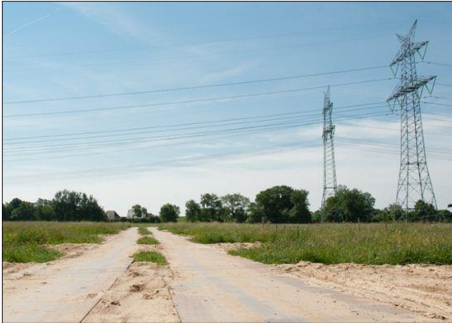
Abbildung 11: Beispiel für eine temporäre Mastzufahrt
