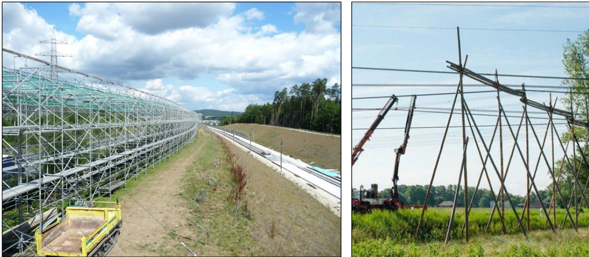
Abbildung 10: Schutzgerüste aus Metall und Holz
