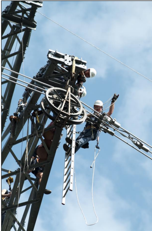
Abbildung 14: Leiterseile liegen während des Seilzugs in den Laufrollen
