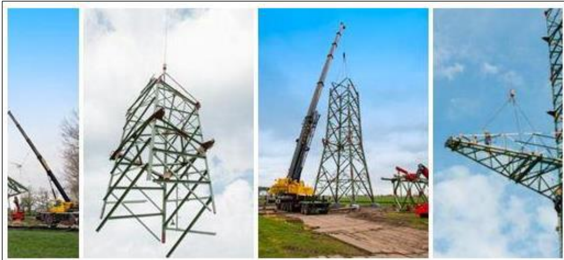
Abbildung 13: Mastmontage mittels Mobilkran
