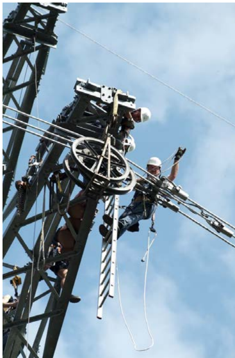
Abbildung 53: Leiterseile liegen während des Seilzugs in den Laufrollen
