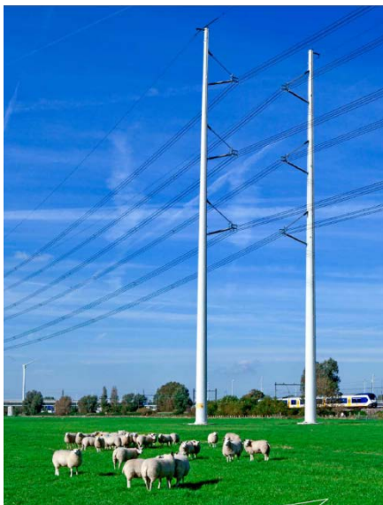
Abbildung 8: TenneT Wintrack-Mast (Niederlande)
