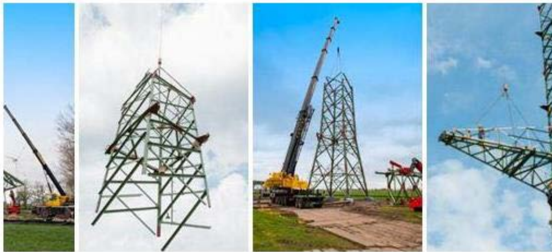
Abbildung 52: Mastmontage mittels Mobilkran
