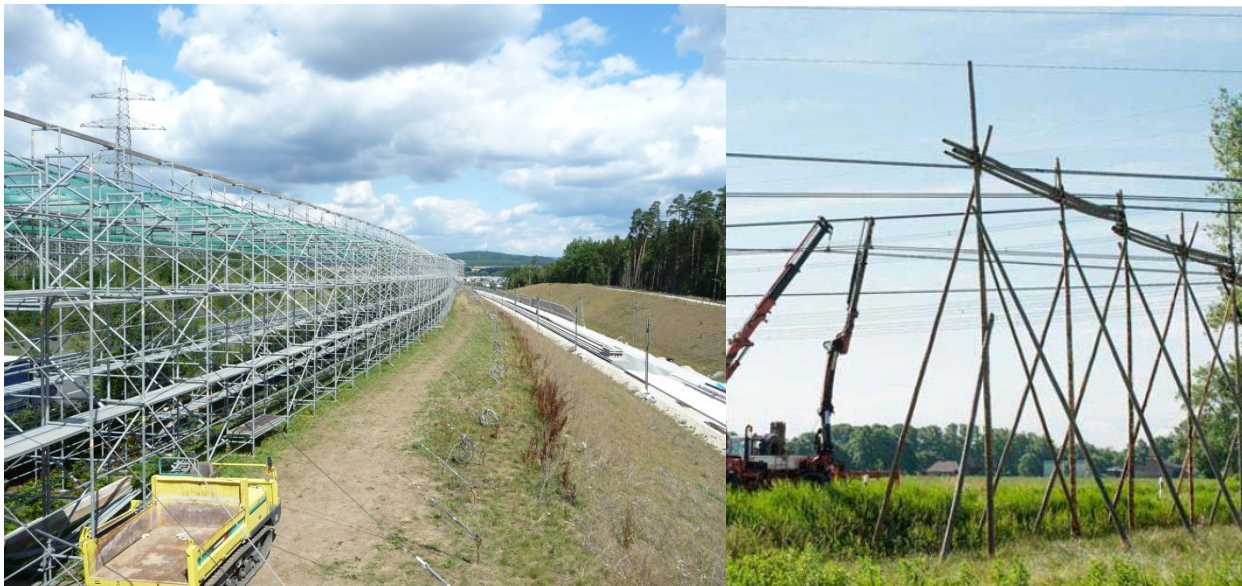
Abbildung 55: Schutzgerüste aus Metall und Holz
