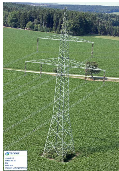
Abbildung 9: 380-kV-Mast Nr. 23 der 380-kV-Ltg. Isar – Pleinting (B117)
