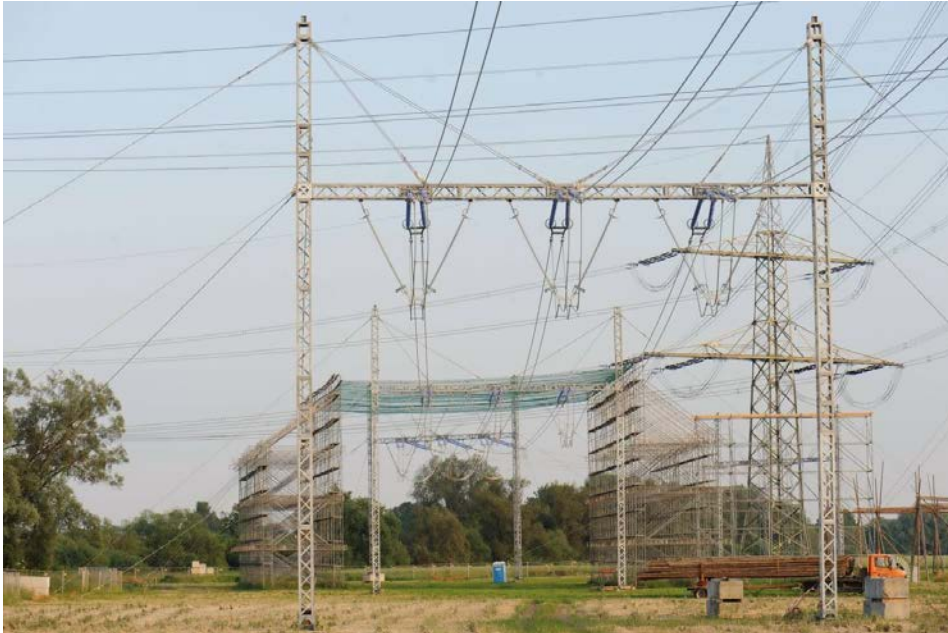
Abbildung 54: Freileitungsprovisorium
