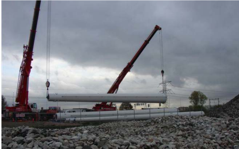
Abbildung 11: Aufstellen von Vollwandmasten mit Kränen
