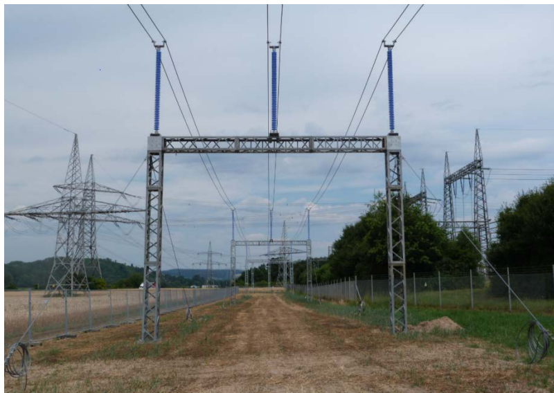
Abbildung 30: Freileitungsprovisorium für ein System mit Abankering
