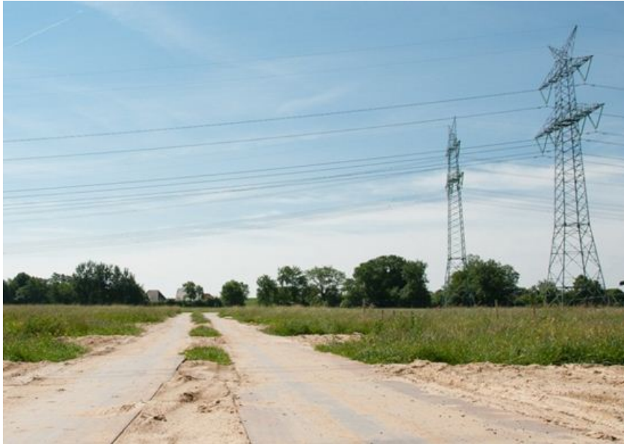
Abbildung 50: Beispiel für eine temporäre Mastzufahrt
