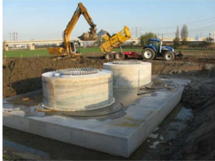
Abbildung 10: Vollwandmast mit zwei Türmen
